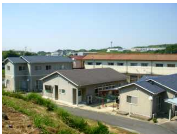
第一清浄ホーム
